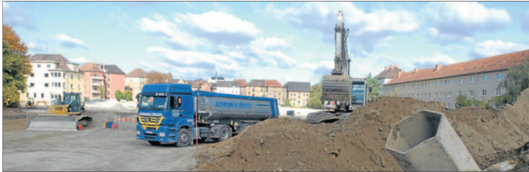
Auf dem Areal des ehemaligen Straßenbahndepots entsteht bis Herbst 2011 ein Wohngebiet.
