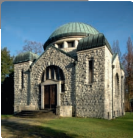
Jüdische Feierhalle auf dem Hauptfriedhof Braunschweig Foto: Ulrich Knufinke
