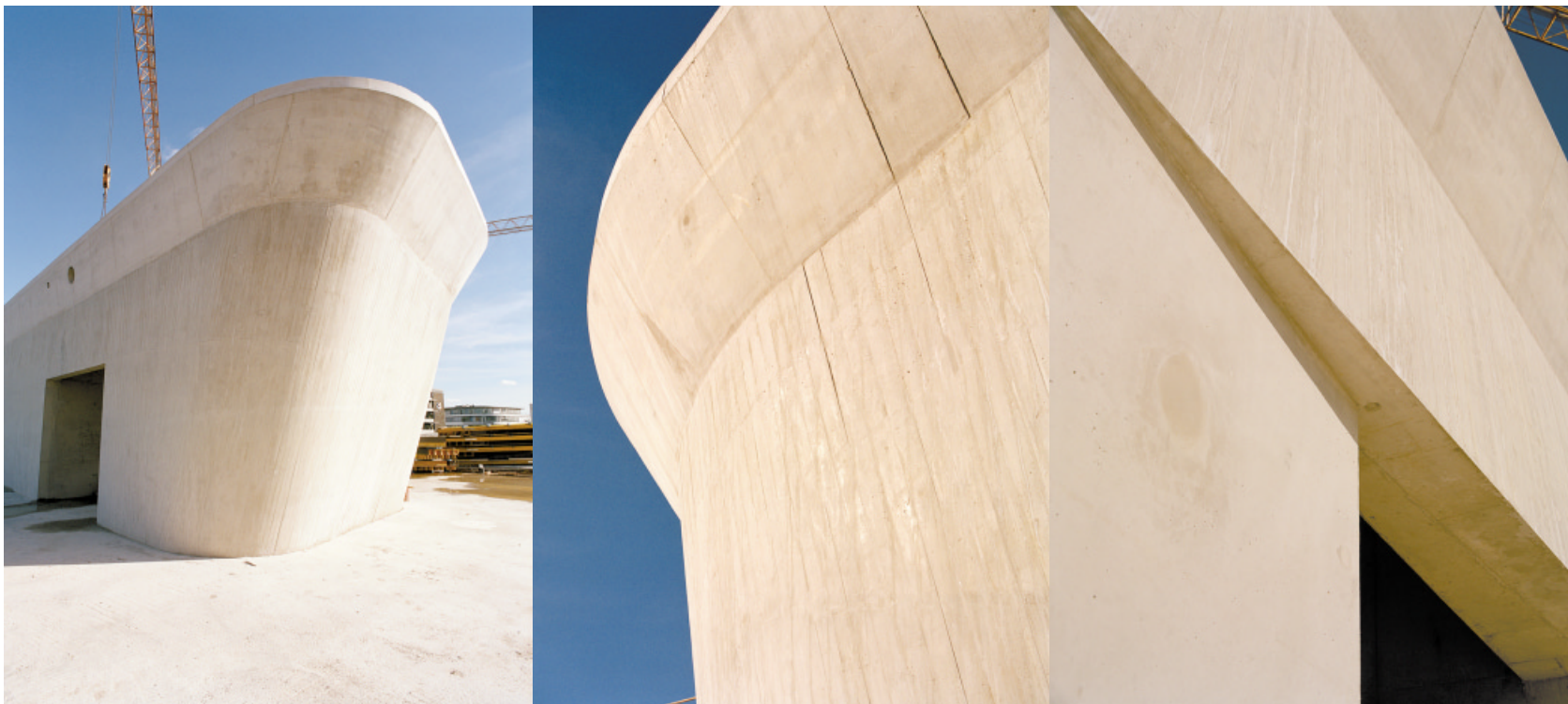
Baustelle Phæno Fotos: Klemens Ortmeier
